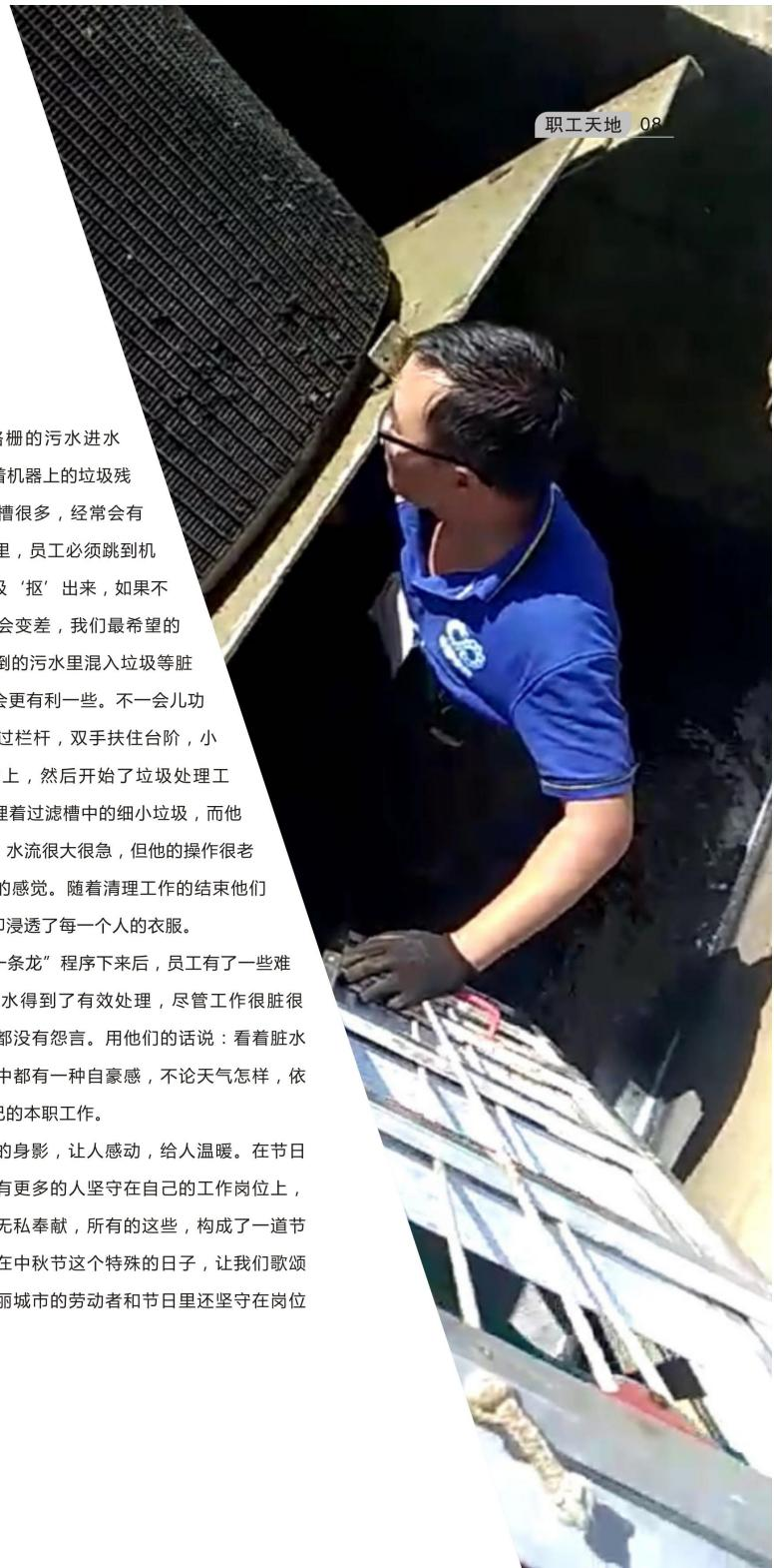
理干净就行。就在细格栅的污水进水口，污水处理工在清理着机器上的垃圾残渣。这些机器里的过滤槽很多，经常会有垃圾堵在过滤板的缝隙里，员工必须跳到机器上面用手把堵塞的垃圾‘扳’出来，如果不及时清理，过滤效果就会变差，我们最希望的还是老百姓们不要在倾倒的污水里混入垃圾等脏物，这样对于处理污水会更有利一些。不一会儿功夫，运行员工熟练的翻过栏杆，双手扶住台阶，小心翼翼地站到过滤器械上，然后开始了垃圾处理工作，他用手一点点的清理着过滤槽中的细小垃圾，而他的脚下就是污水进水口，水流很大很急，但他的操作很熟练，给人一种平静的感觉。随着清理工作的结束他们难得的休息一下，汗水却浸透了每一个人的衣服。
