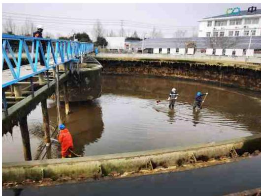
2022年2月8日，春节假期刚刚结束，我司城北厂根据工作计划，对西二沉池刮吸泥机进行维修改造。公司组织技术人员结合现场情况制定了抢修方案，为确保设备维修顺利进行，首先下达的任务就是放空池体，清理底部积泥及杂物，该池体使用年限久长，底部积泥严重，清理难度大。由于时间紧、任务重，安全生产监督管理部部门负责人关飞、安全运营部副主任兼城北厂厂长李晓芳、城北厂副厂长姜龙亲自带队下池清理。
